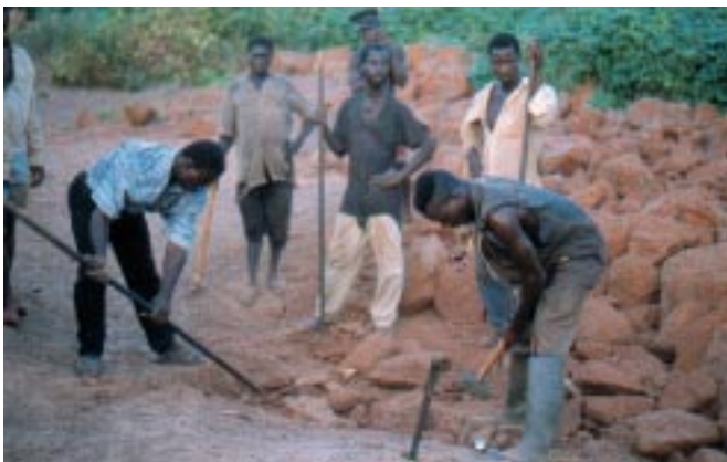
Mit Stemmeisen und Spitzhacken machen die Bauern verkrustete Lateritböden Meter für Meter wieder urbar.
